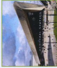
In 2014 is het nieuwe centraal station van Rotterdam geopend; een openbaar vervoerknooppunt waar dagelijks meer dan 110.000 mensen gebruik van maken. Waar voorheen het regenwater op de sporen viel, wordt het nu opgevangen door de grote glazen kap en daarna langzaam gefiltreerd in de grond en de omliggende singels.
